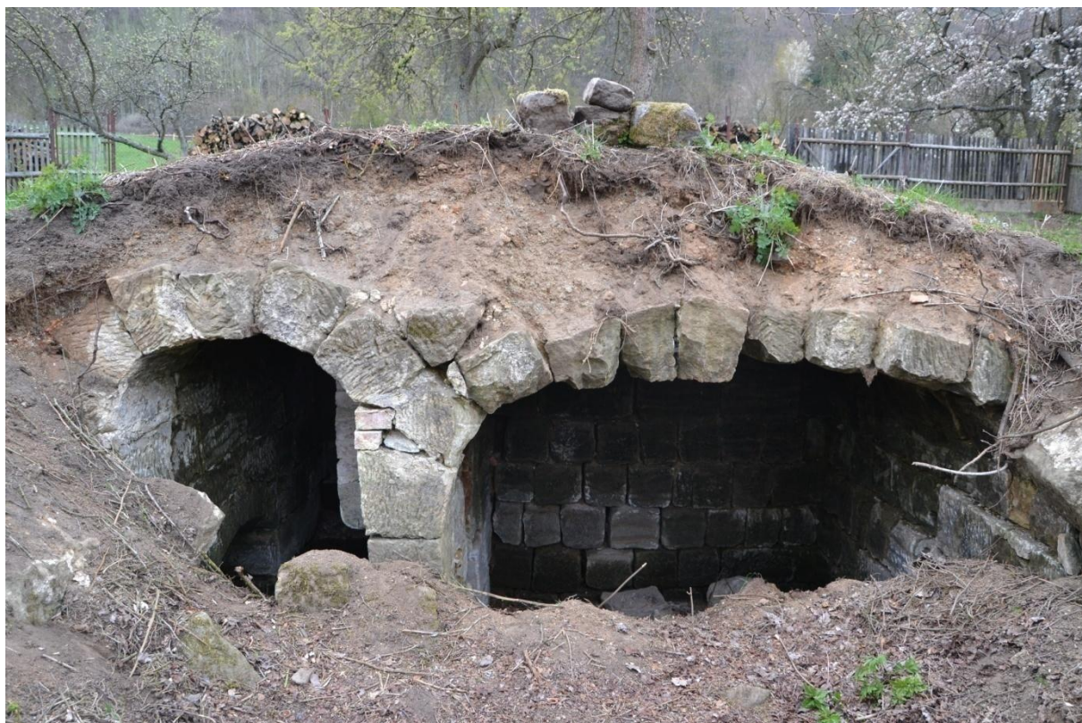
Obr. 5: Rané čp. 24 (okres Česká Lípa), pohled na čela kleneb severní části sušárny ve směru z manipulační komory A, vpravo sušící komora B, vlevo prostor u topeniště C – klenba je zjevně nasazená asymetricky. Foto M. Kolka, 2019.
