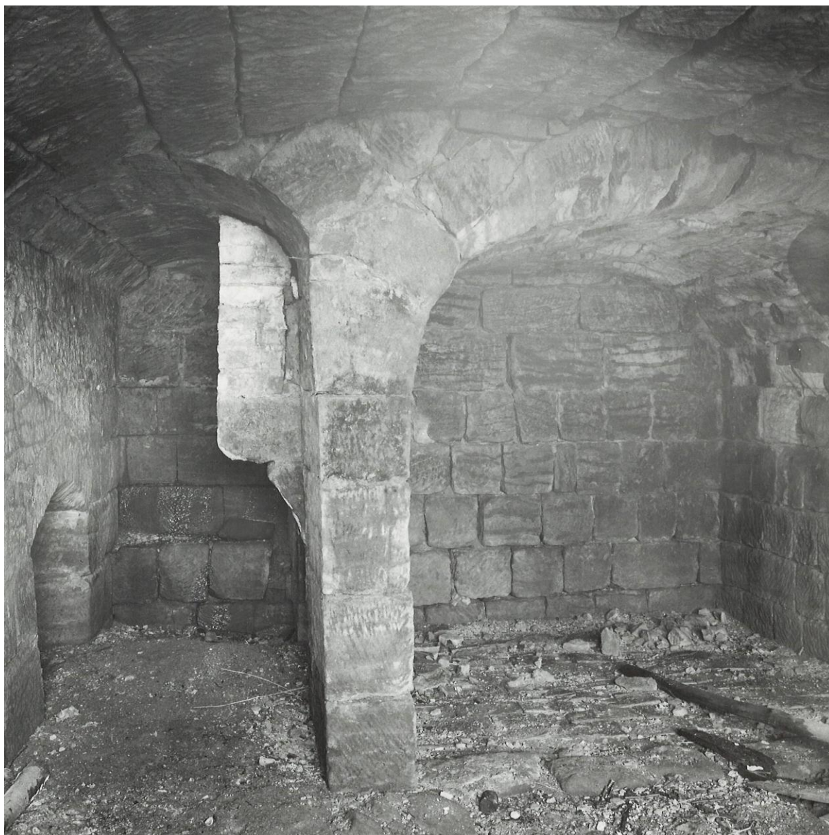
Obr. 9: Rané čp. 24 (okres Česká Lípa), pohled z manipulační komory A na sušicí komoru B (vpravo) a prostor u topeniště C (vlevo), především u sušicí komory je patrná původní úroveň podlahy. Foto J. Škabrada, 1981 (SHP vesnice Rané).
