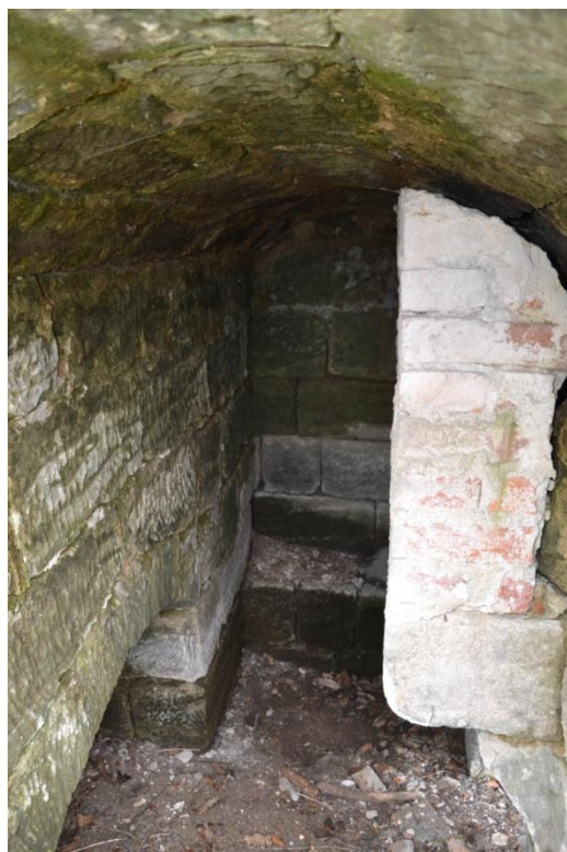
Obr. 8: Rané čp. 24 (okres Česká Lípa), pohled do prostoru u topeniště C, vpravo je patrný sopouch dymníku, vysazený na pískovcových krakorcích, u zadní stěny lavice s pískovcových kvádrů a vlevo nika pro uložení dřeva. Foto M. Kolka, 2019.
