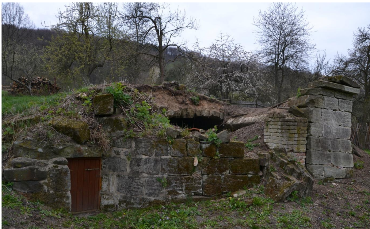
Obr. 3: Rané čp. 24 (okres Česká Lípa), pohled na sušárnu ovoce od jihozápadu, na sušárnu navazuje zleva stěna se vstupem ke studánce, západní stěna sušárny je zcela zakrytá splachovým kuzelem a destrukcí, uprostřed druhotně zmenšený vstup, vpravo torzo korunní římsy a zdiva štítu. Foto M. Kolka, 2019.
