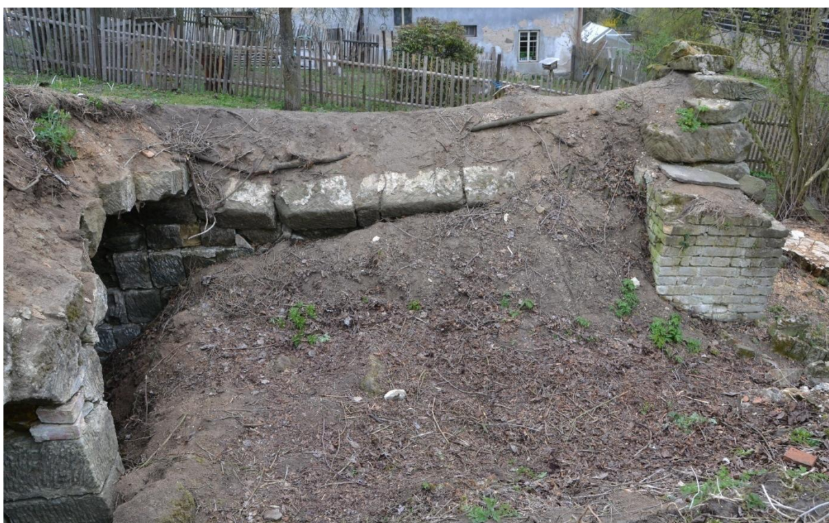
Obr. 4: Rané čp. 24 (okres Česká Lípa), pohled na torzo manipulační komory A se zřícenou klenbou, jejíž náběh je patrný na východní stěně, vpravo cihelná dozívka vstupu, vlevo sušící komora B a prostor u topeniště C. Foto M. Kolka, 2019.
